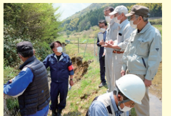
建設中の太陽光発電所を現地調査
